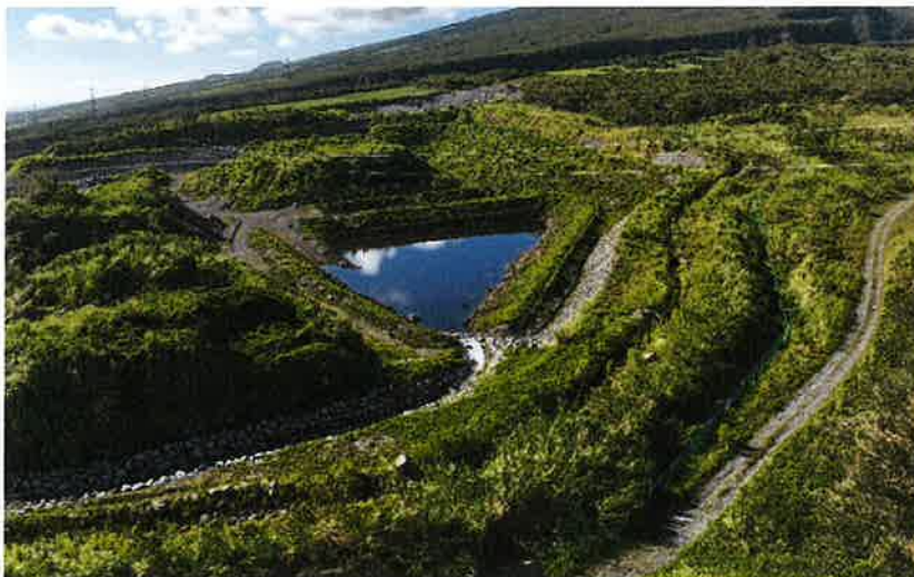
Exemple d'un bassin et d'un fossé en enrochements sur le site TGBR de Sainte Anne
